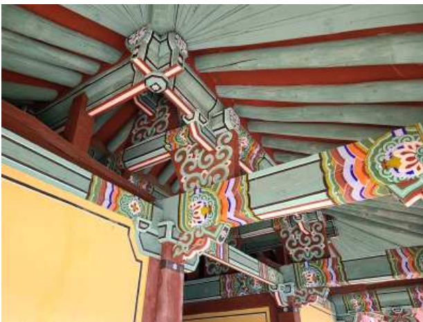
그림 20 침류각의 상부 가구 구성. 중도리 아래에 직각 방향으로 (2023.03.17. 촬영)
