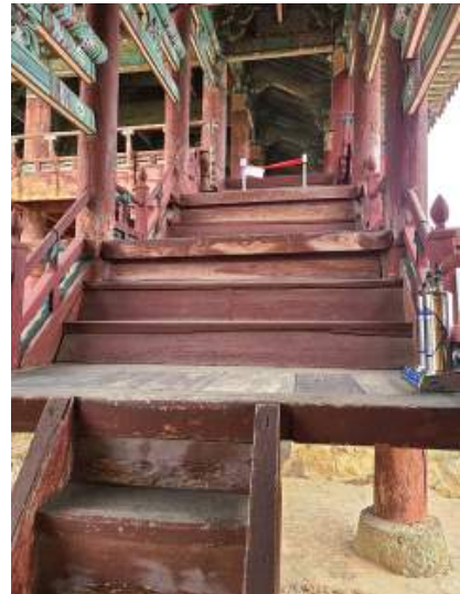
그림 23 여수각 내부 계단 (2023.03.17. 촬영)
