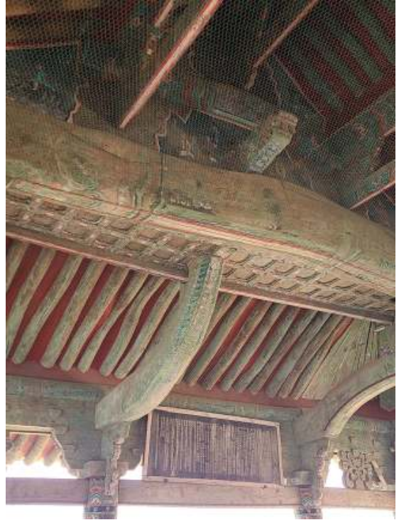
그림 10 측면 중앙 기둥 위에 있는 층량의 모습, 내만곡한 곡선을 이루며 눈썹지붕을 뚫고 올라가 대들보 위에 걸려 있다. (2023.03.17. 촬영)
