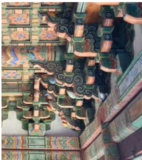
그림 9 수타사 대적광전의 공포 내부 모습
