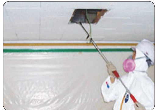
[그림 26] 코팅텍스 뒷면의 습윤제 분무 예시
