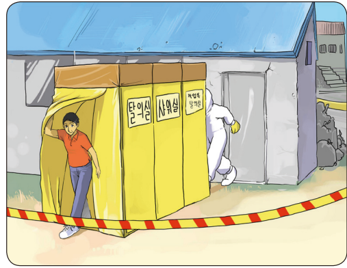
[그림 14] 해체·제거작업 인근에 설치된 위생설비
