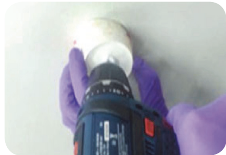
컵과 면도크림을 이용한 구멍 뚫기
