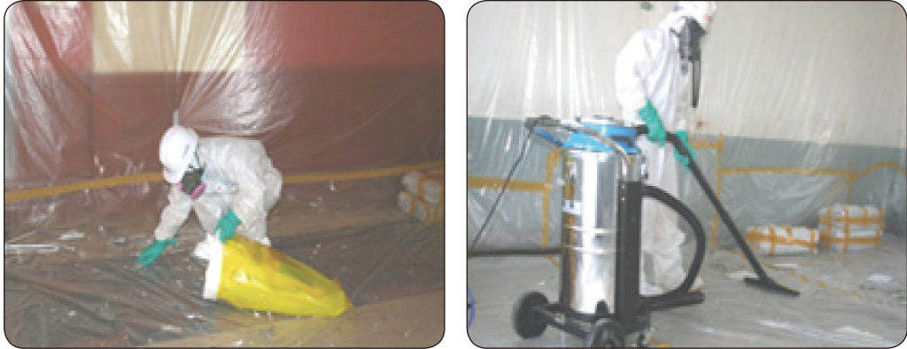
[그림 28] 석면함유 잔재물의 청소 모습
