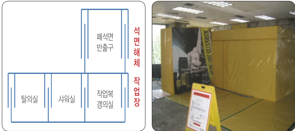
[그림 30] 석면폐기물 반출구 설치 예시
