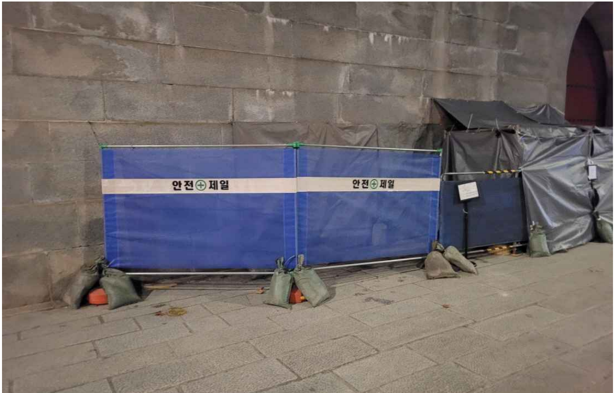
임시 가림막 추가 설치 ('23.12.18. 오전 12:50분)
